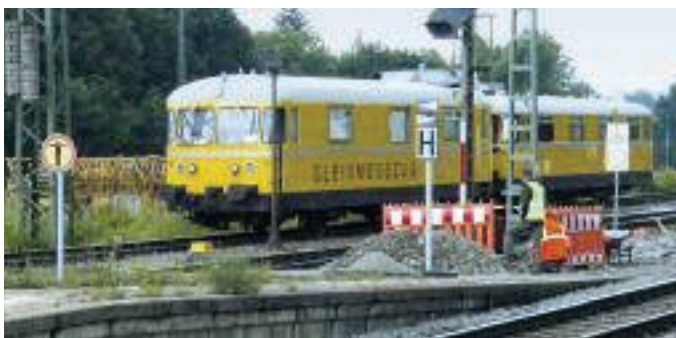
Abb. 2: Sicherungspersonal in der Funktion des Absperrpostens
